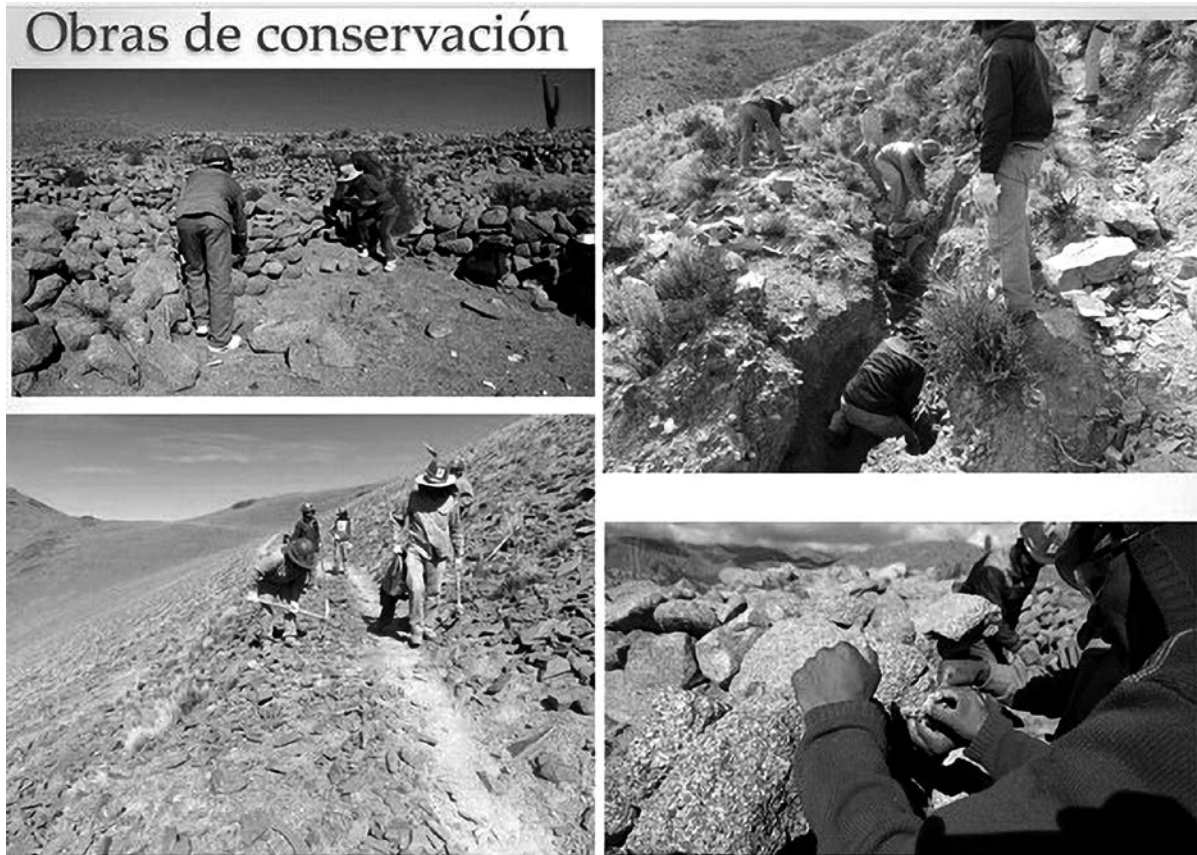
Figura 31: Imágenes de las obras de conservación llevadas a cabo en recintos y caminos entre Tastil y Las Capillas.
