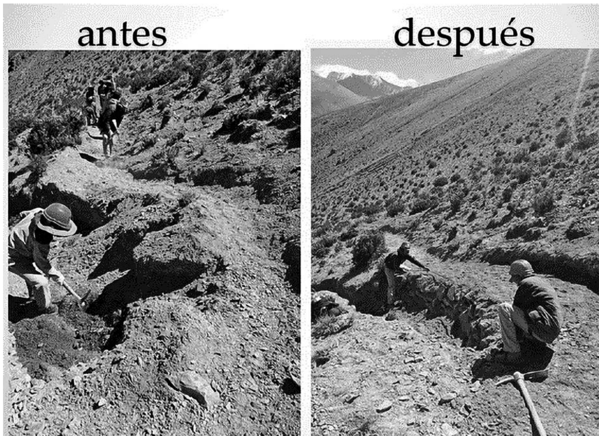
Figura 32: Restauración de un segmento de camino afectado por la acción hídrica.
