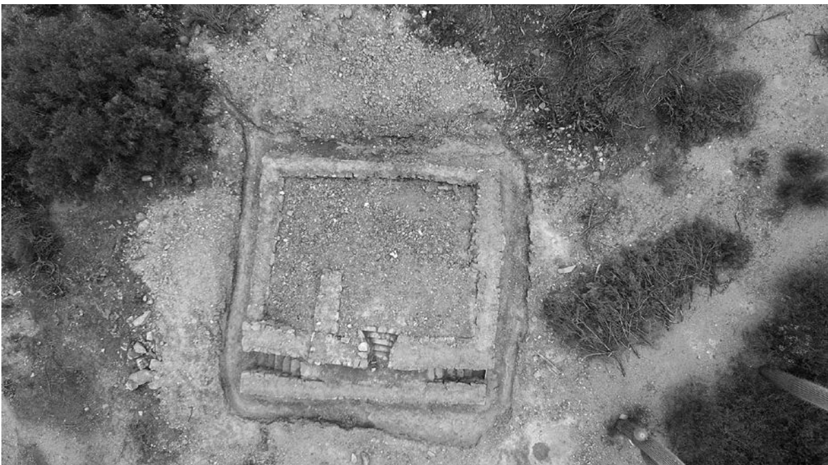
Figura 56: Ushnu o plataforma ceremonial ubicado en la parte central de la Plaza o Aucaypata luego de las obras de restauración. Fotografías Christian Vitry y Niv Schmilchuk (Drone).
