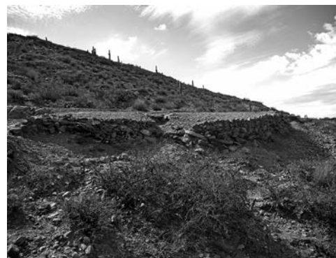
Figura 48: Sangrías y muros de contención, contruidos para estabilizar el sector.
