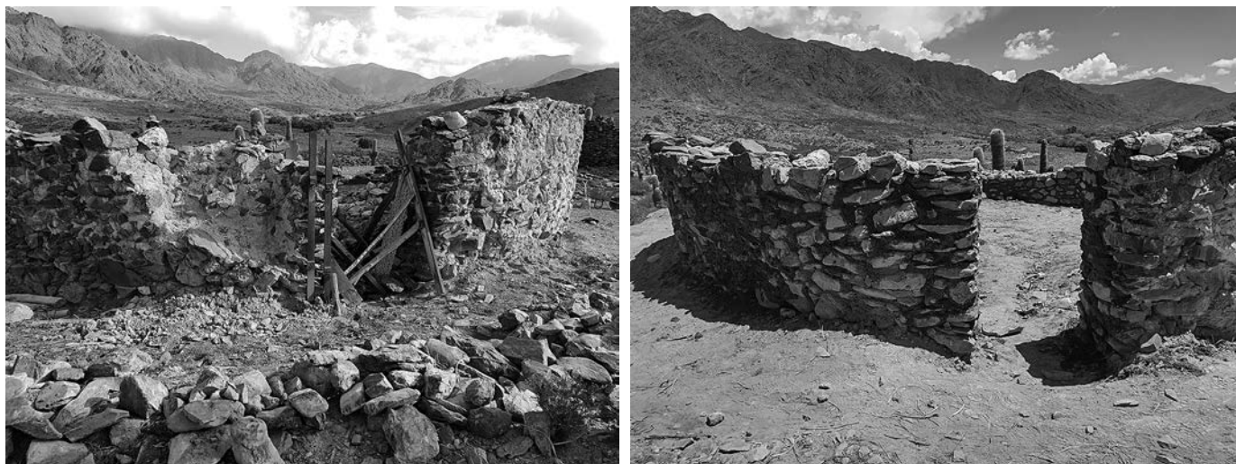
Figura 59: Collca Oeste antes y después de la restauración. En la puerta se aplicó la técnica de anastilosis. Fotografías Christian Vitry.
