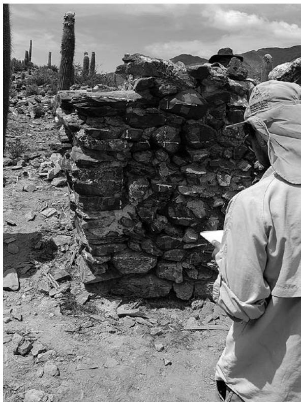
Figura 60: Izquierda: proceso de registro gráfico (dibujo y fotografía) y marcado de la retícula sobre el muro para realizar la anastylis. Derecha: Muro restaurado. Fotografías Christian Vitry.
