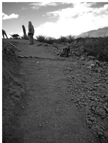
Figura 48: Sangrías y muros de contención, contruidos para estabilizar el sector.
