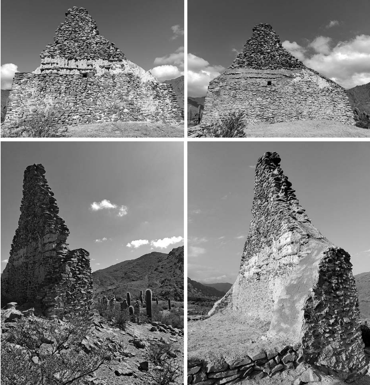
Figura 54: Hastial de la Kallanca de Potrero de Payogasta antes y después de las tareas de restauración. Fotografías Christian Vitry.
