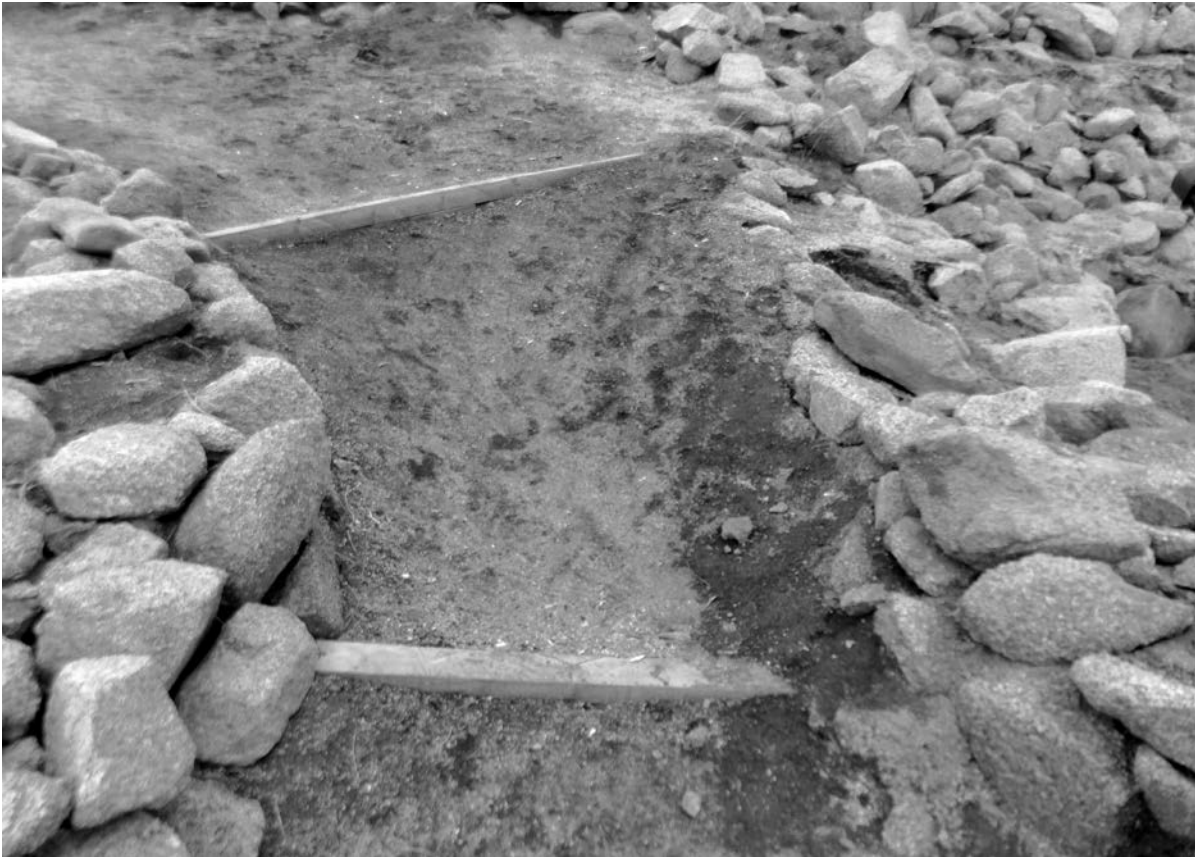
Figura 27: Tabiques de madera transversales al camino para evitar la erosión del suelo por el tránsito de los visitantes. Fotografía Christian Vitry.
