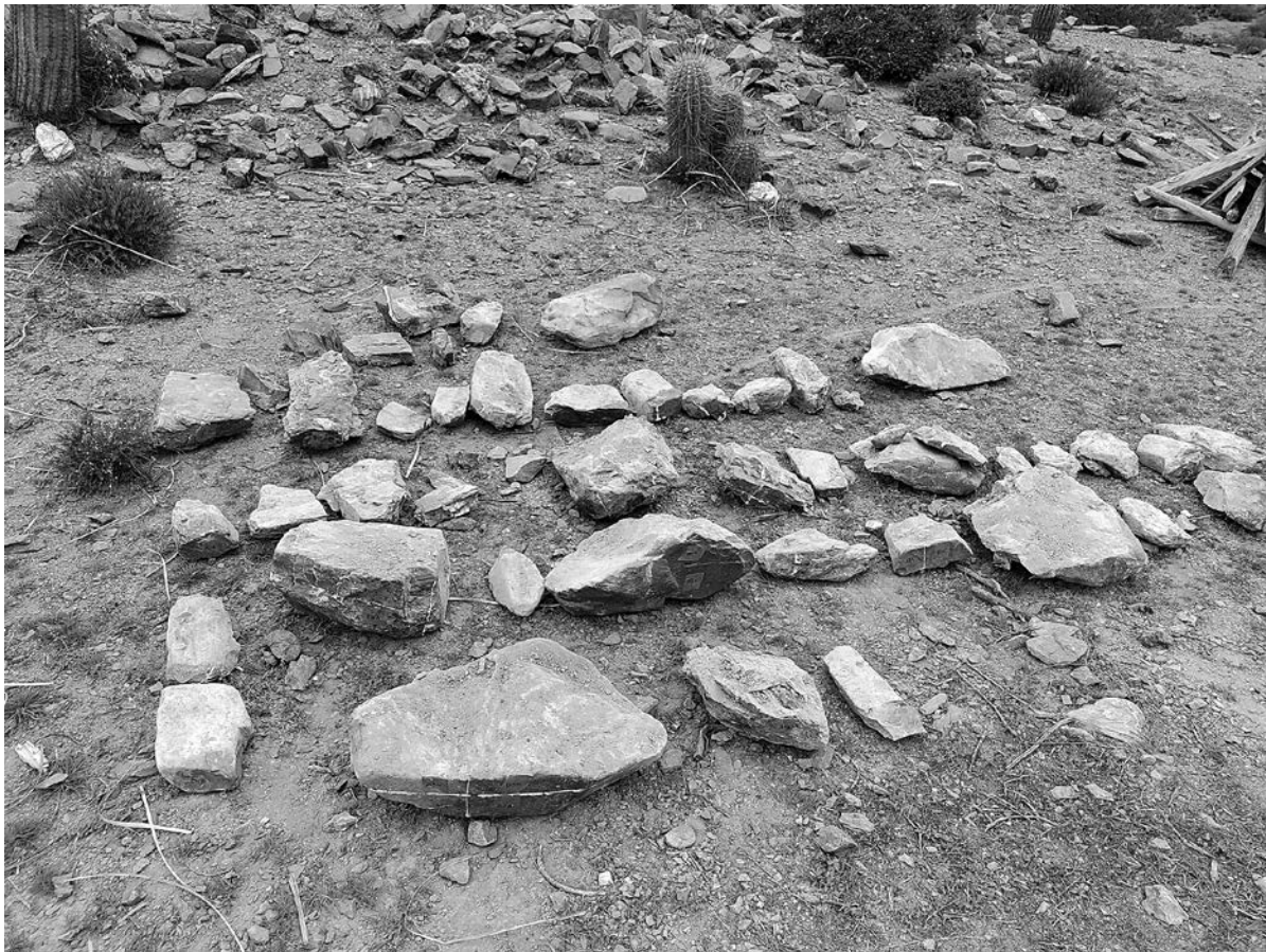
Figura 62: Rocas dispuestas en filas y columnas luego de haber desmontado el muro. Las piezas que están en malas condiciones fueron reemplazadas. En base al dibujo y eventualmente fotografías, se remontó el muro localizando cada roca en el mismo lugar que estaba, este proceso se conoce como anastilosis. Fotografía Christian Vitry.
