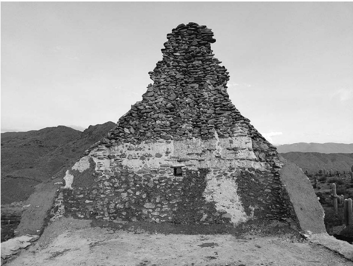
Figura 65: Estado actual del hastial de la kallanca de Potrero de Payogasta luego de los trabajos de restauración en febrero de 2022. Fotografía Christian Vitry.
