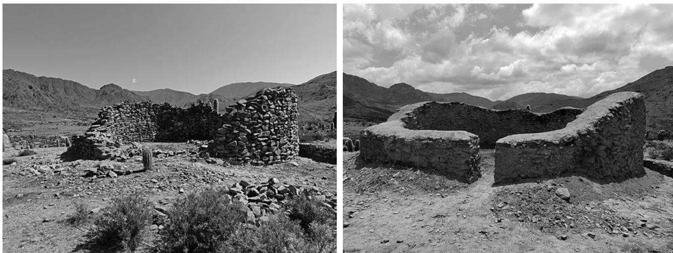
Figura 58: Collca Este antes y después de las obras de conservación realizadas en enero de 2022. Fotografías Christian Vitry.
